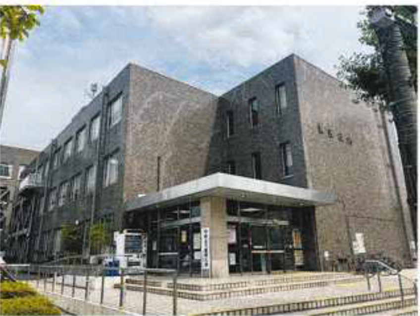
築50年以上が経過し、老朽化が進む東区役所
